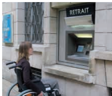
Distributeur inaccessible avec commandes trop éloignée sans possibilité de se rapprocher.
