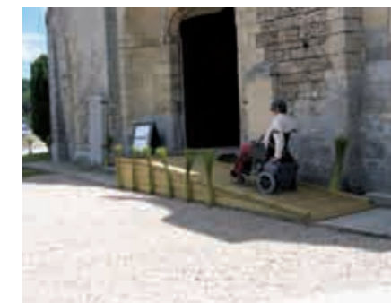
Plan incliné de 1,20 m de large, avec bordure chasse-roue, palier de repos de 1,50 de diamètre en haut devant la porte pour effectuer le demi-tour et entrer dans l'église du Bourg Dun.
