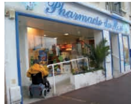
Plan incliné de la pharmacie du port à St Valery en Caux. Une grande partie de la clientèle apprécie cet aménagement.
