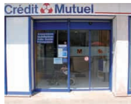
Les trottoirs peuvent être décapés et repris pour arriver au niveau du seuil d'une porte et rendre l'établissement accessible comme l'a fait une banque valeriquaise.
