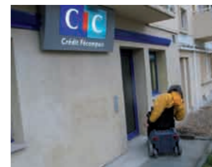
En aménageant son entrée secondaire avec bouton d'appel cette banque valeriquaise est maintenant accessible. Le nombre de marches de son entrée principale rendait impossible la réalisation d'un plan incliné.
